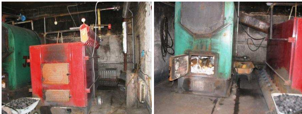
Bet rezerves un remontā laikā ar šķidra kurināmo katlu ATLAS (Q=710kW) palīdzību.
